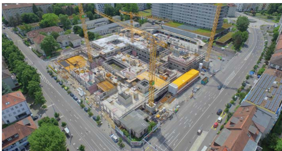
Das Felix Platter-Spital mit der aktuellen Baustelle (Stand Juni 2016).
